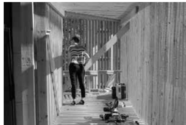
Kuraator inspekteerib valmivat treppi.
